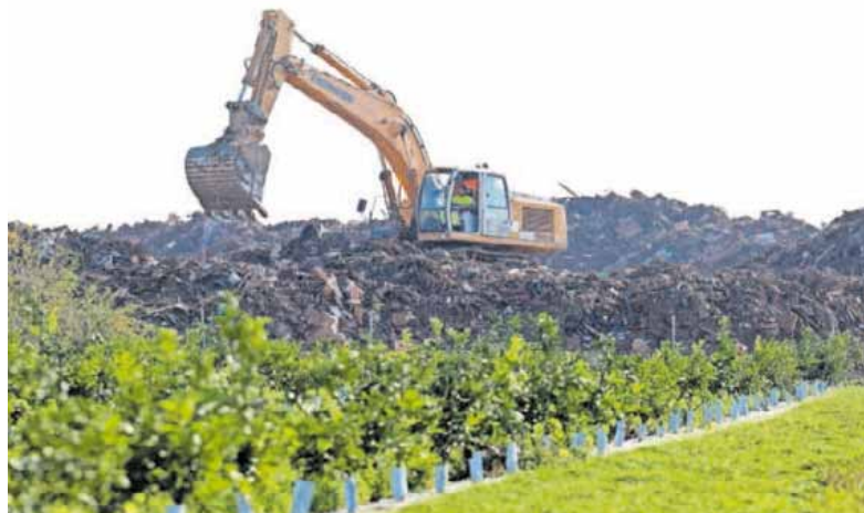
Una excavadora trabaja en la antigua cantera de Picassent convertida en vertedero. JAIME VILLANUEVA
