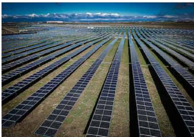
Parque solar construido por el Grupo Lantania en Torrijos, Toledo. Imagen cedida por la empresa. Lantania
