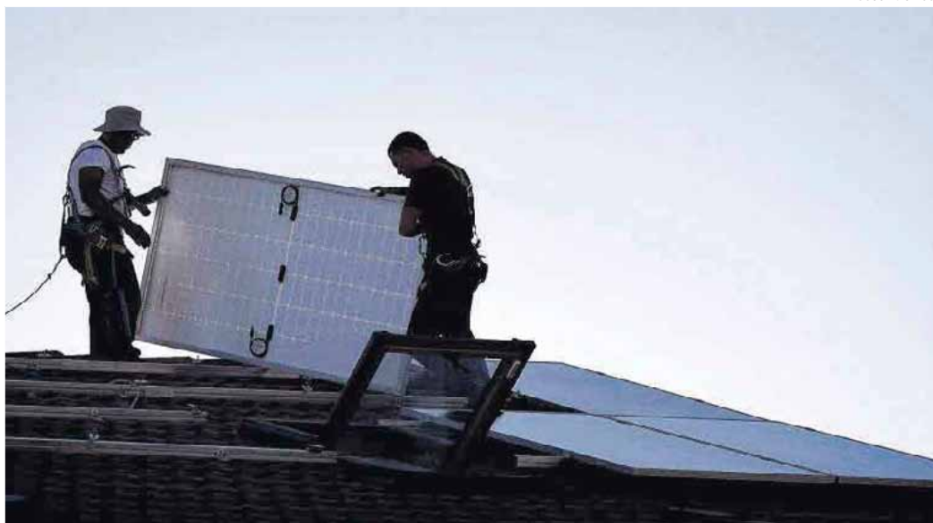
Dos operarios instalan placas solares fotovoltaicas en una vivienda.
